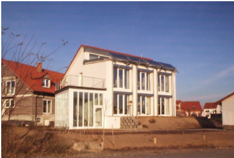
Bild 2: Solar-Passivhaus in Büchenau mit einem Lüftungs-Kompaktgerät Aerex, einem 30 m langen Erdreichwärmetauscher und einer 8 m 2 großen thermischen Solaranlage
