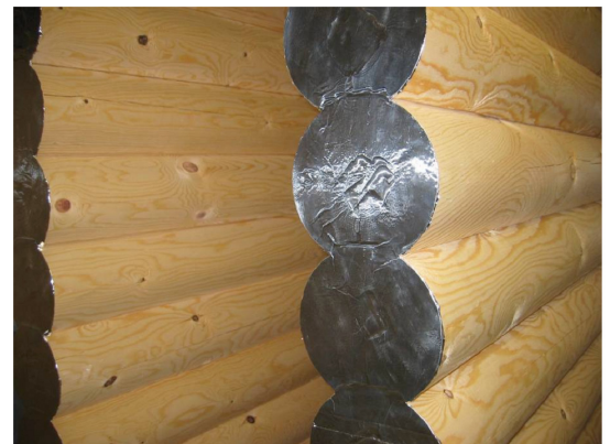
Bild 9: Fotografische Aufnahme der Rundbohlen-Wandelemente mit dampfdicht versiegelter Stirnseite. Diese Wandelemente wurden auch ohne Stirnseitenversiegelung untersucht.
