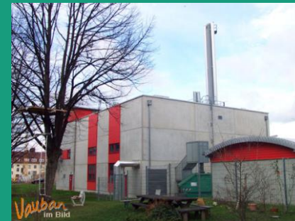
Mittlere und große KWK (Wärmenetze) ~ 60 GW el
