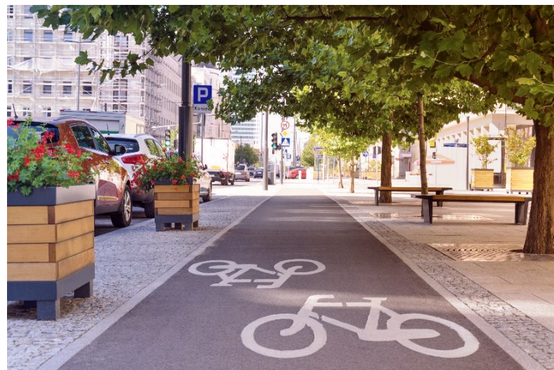
Abbildung 19: Fahrradweg baulich getrennt von der Fahrbahn (Bild: Lanski, Quelle: Shutterstock Inc. o. J.f)
