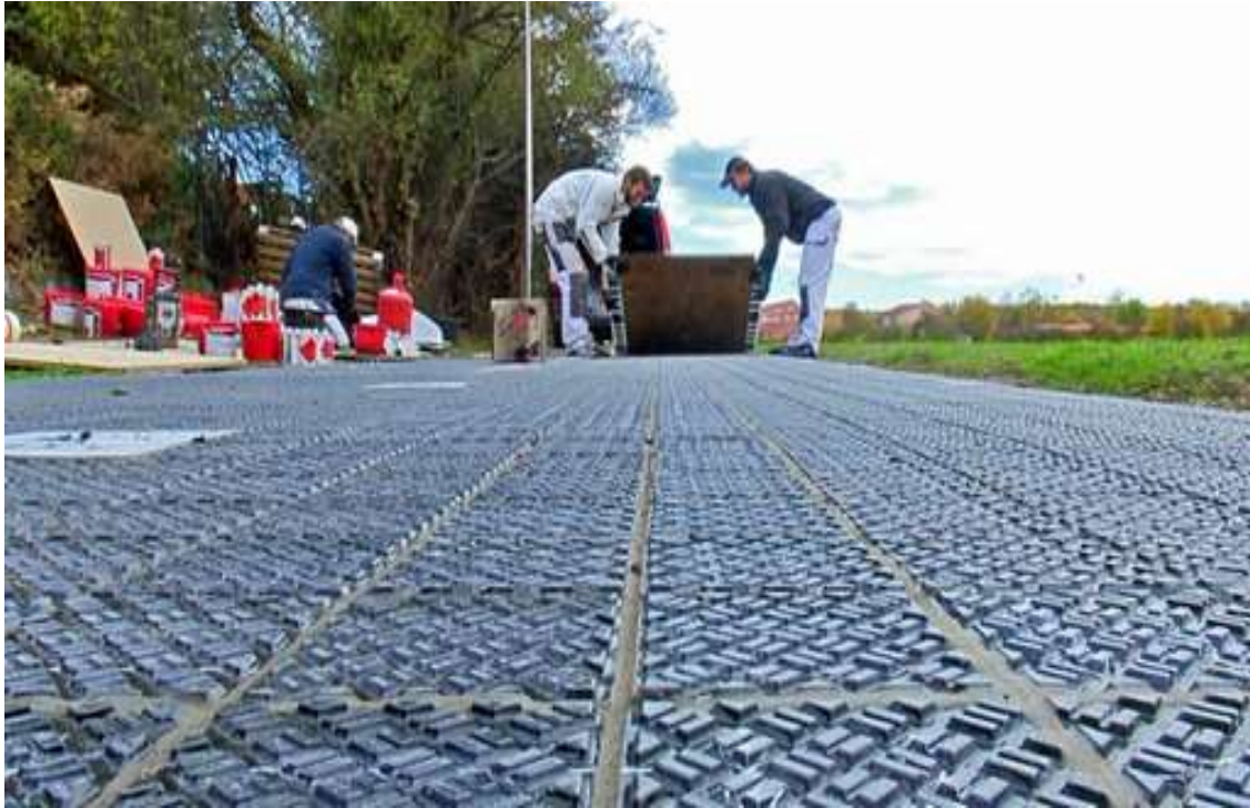
Solarradweg 200 m 2 Fläche, 12 MWh/a Strom, Solmove Technologie (WDR 2018)
