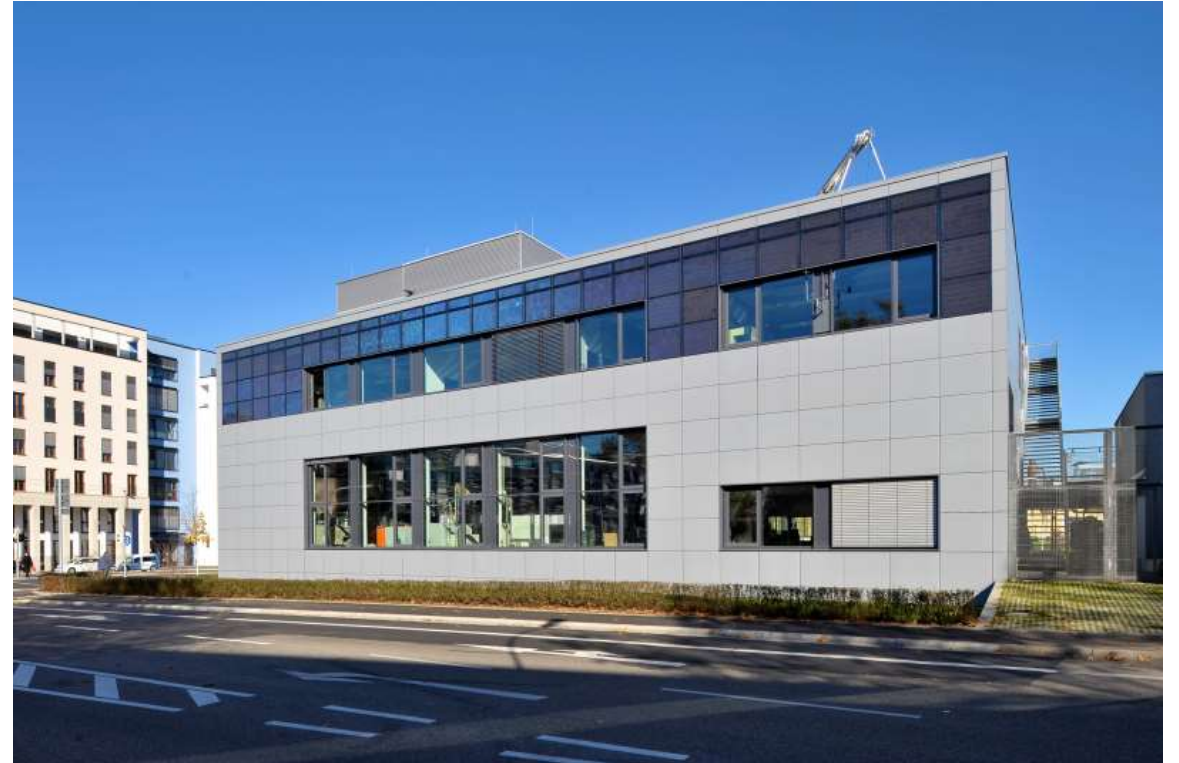
Bauwerkintegrierte PV (ISE-Labor)
