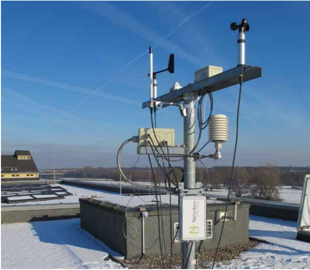
LPWAN-Gateway auf einem Gebäude des Fraunhofer IFF. Foto: Fraunhofer IFF
