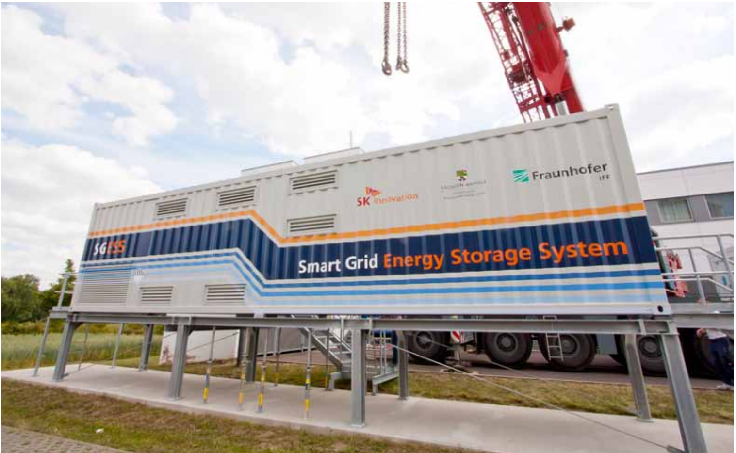
Mobiler Energiespeicher des Fraunhofer IFF. Fünftausend Batteriezellen stecken in dem Container (siehe Bild linke Seite). Fotos: Fraunhofer IFF, Daniela Martin
