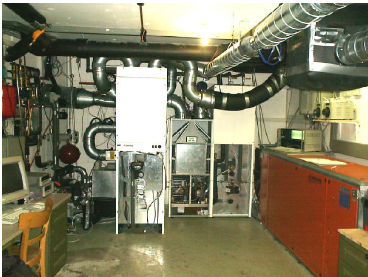
Bild 2: Teststand des Fraunhofer ISE für Lüftungskompaktgeräte
