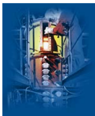
Ein Mitarbeiter des IFK bei Messungen an der KSWA-Kohlenstaubverbrennungsanlage
