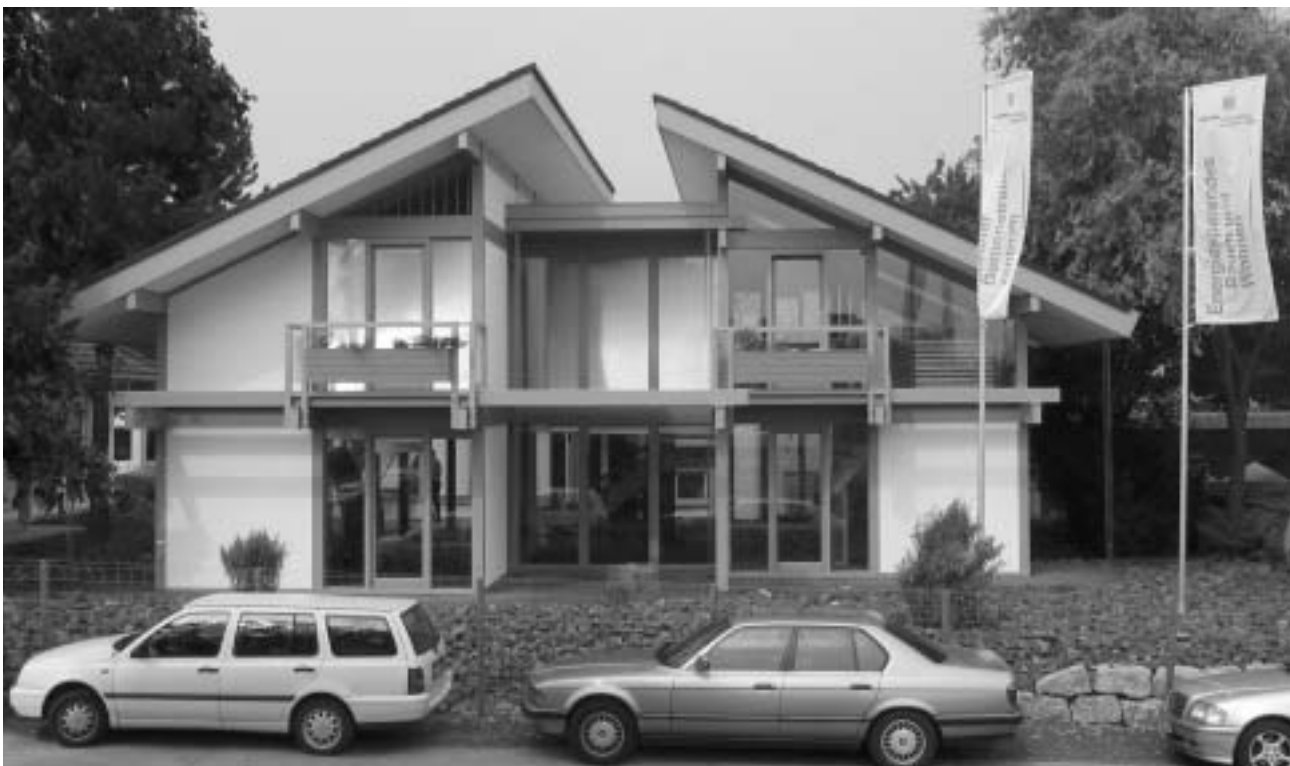
Bild 2: Photographische Ansicht des Demonstrationszentrums in Fellbach.
