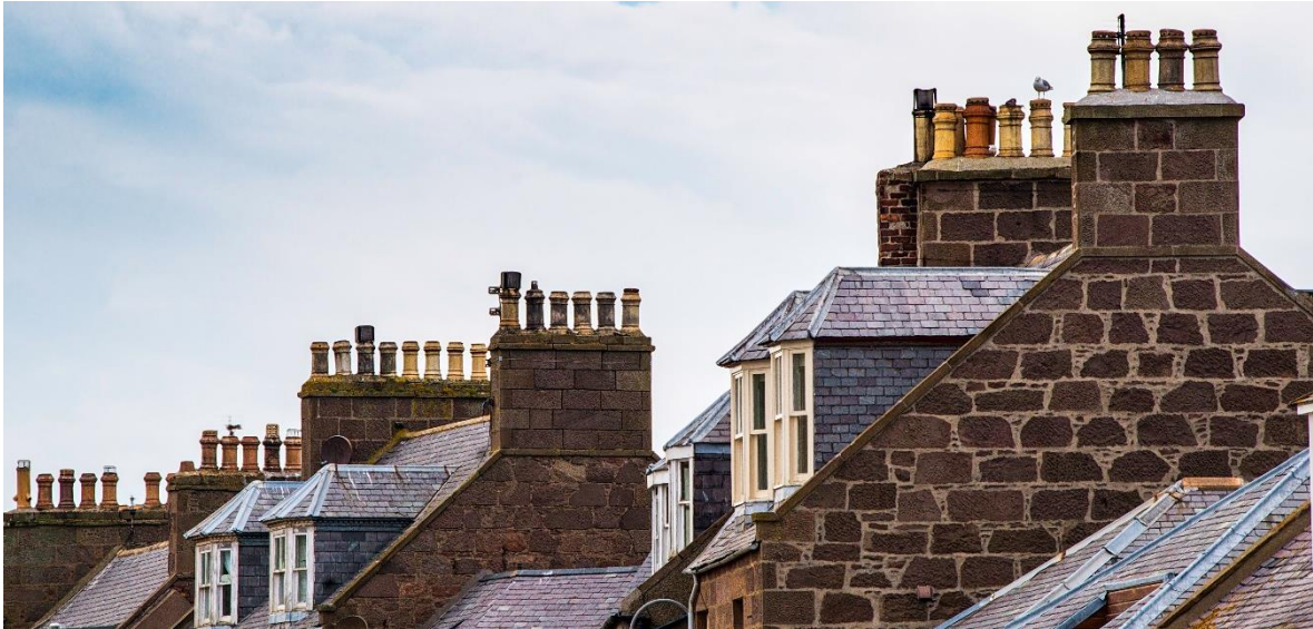
Abbildung 41 – Separate Schornsteine pro Feuerstätte. (Quelle: pixabay, Lizenz: CC0)
