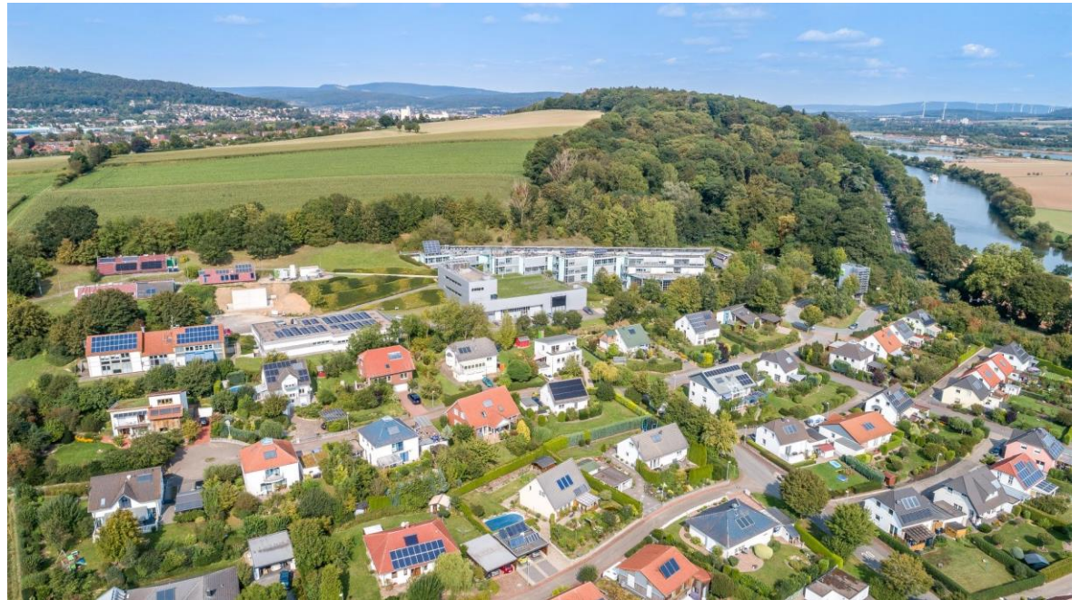
Solarsiedlung am Südhang des Ohrbergs bei Hameln ( © ISFH)
