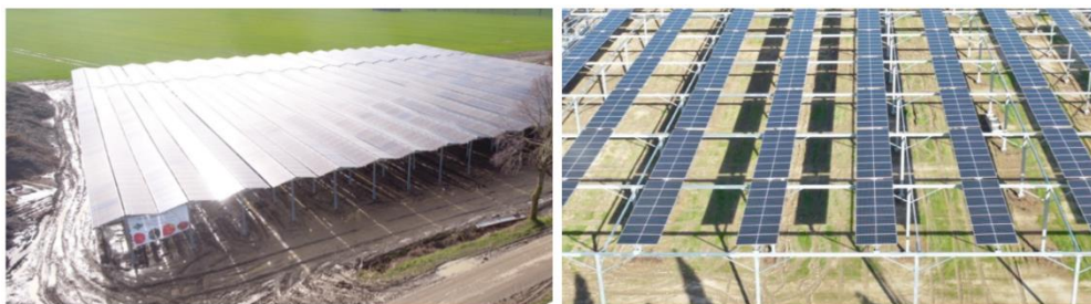
Fig. 7 beispielhafte Darstellung eines geschlossenen (links) und eines nachgeführten (rechts) Systems. (Quelle: VIRIDI)
