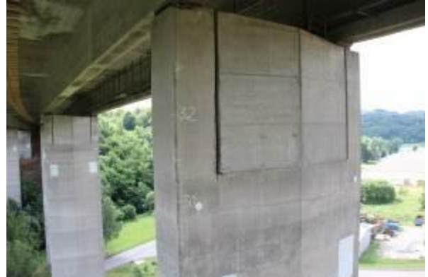
Fig. 11 : Prise de vue aérienne UAS du pilier 5, côté nord
