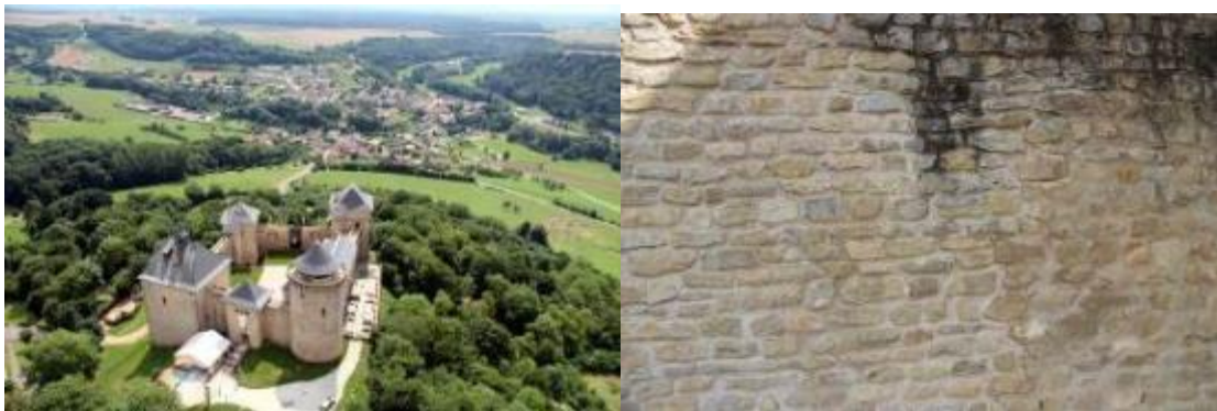
Fig. 3 : À gauche : Prise de vue du haut du Château de Malbrouck, orientée vers le sud. À droite : Gros plan UAS de la cours intérieure, entrée
