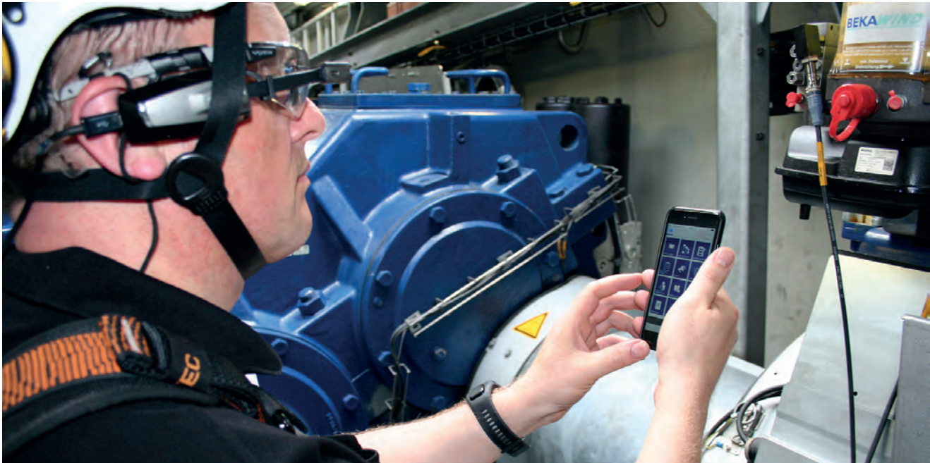
Einsatz digitaler Assistenzsysteme bei der Inspektion einer Windenergieanlage
