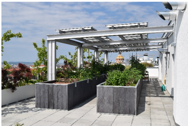
Abbildung 13: PV-Pergola bei einer intensiven (Teil-) Dachbegrünung (Quelle: BuGG)
