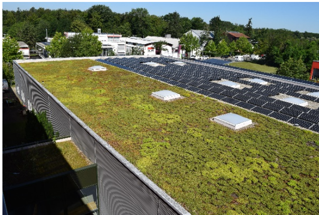
Abbildung 12: Getrennte Verlegung von PV und Begrünung auf einem Dach (Quelle: BuGG)
