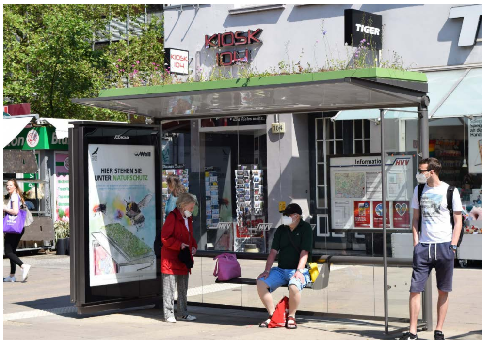
Abbildung 30: Begrünte Dachfläche der Fahrgastunterstände in Hamburg (Quelle: BuGG)
