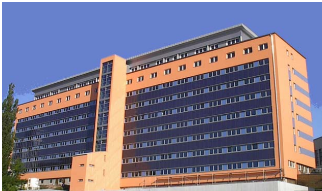
Abbildung 3: Fassadenintegration in Jena und in München, Fotos: GSS-Gebäudesolarsysteme GmbH
