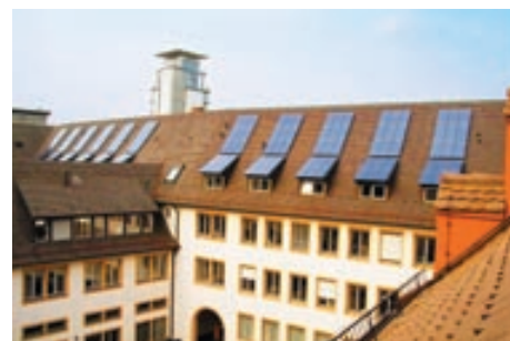
Solares Rathaus Freiburg
