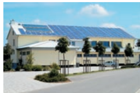
Beteiligungsanlage auf der Festhalle in Wyhl
