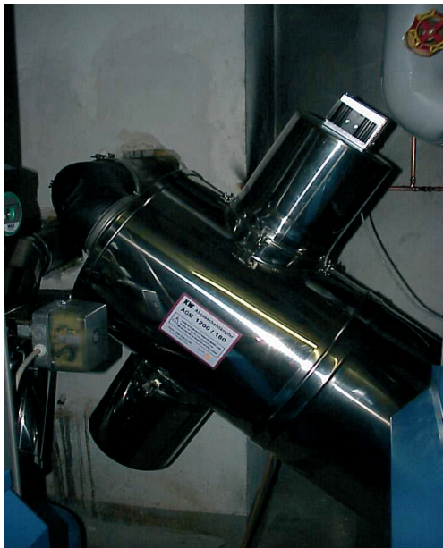
Bild 3: Aktiv+ Schalldämpfer [5] mit zusätzlichem reaktivem ( \lambda/4 ) Abzweigresonator (Foto: Kutzner+Weber).
