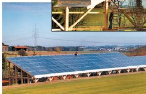
Bild 13 Kran-Montage eines SOLARroof FDKKollektorelements auf einer Sporteinrichtung (Sommerstockbahnhalle Attenkirchen). Der Kollektor speist die Solarwärme in ein Nahwärmenetz mit Saisonspeicher.
