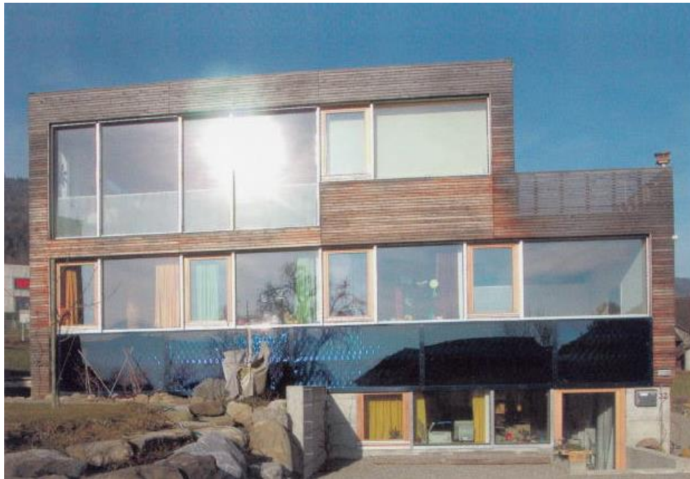
Abbildung 6: Sichtbarkeit der unregelmäßigen Absorberoberfläche [2]
