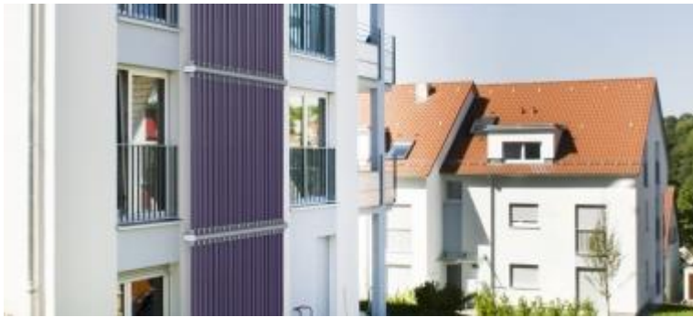
Abbildung 43: Fassadenanbringung von Vakuumröhren der Firma airwasol [15]
