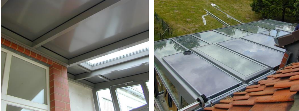
Abbildung 33: Kollektorintegration in das Dach eines Wintergartens [4]
