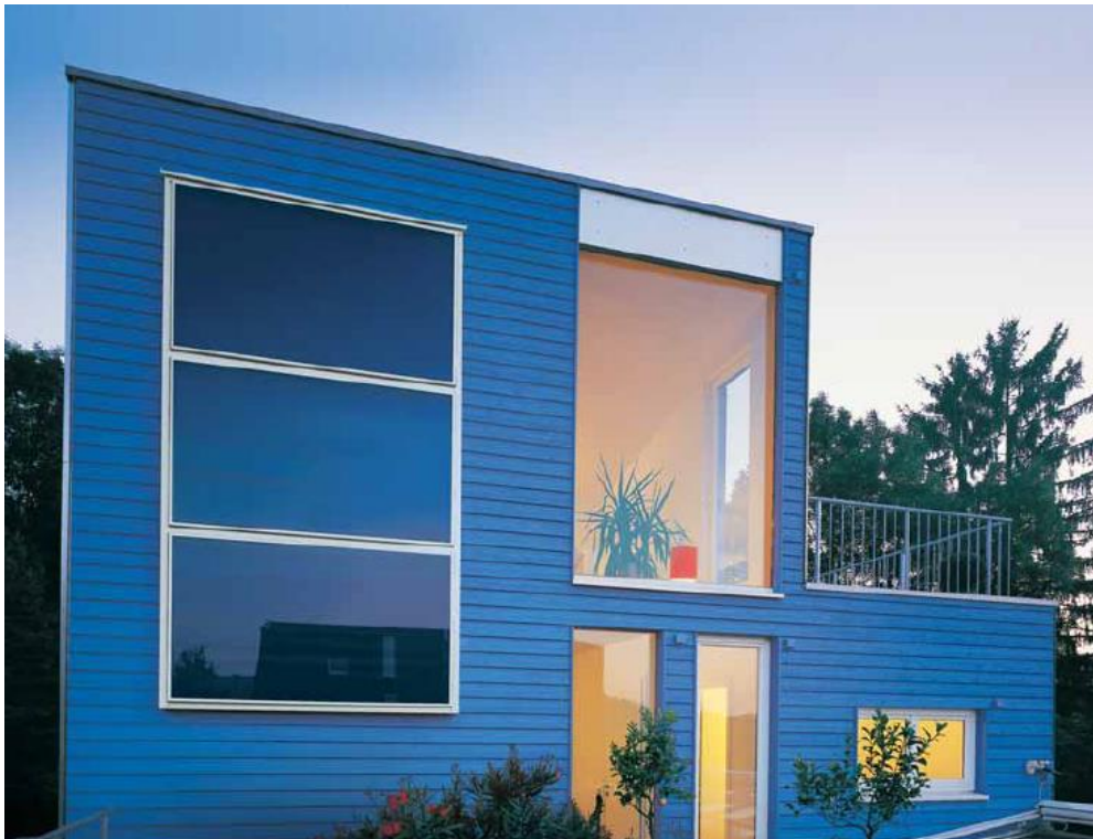
Abbildung 34: Fassadenintegration eines maßgeschneiderten Kollektors, Auszug aus einem Werbeprospekt
