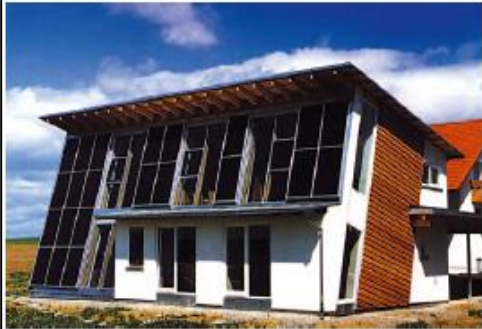
Bild 11 24 m² SOLARroof Fassadenkollektor
