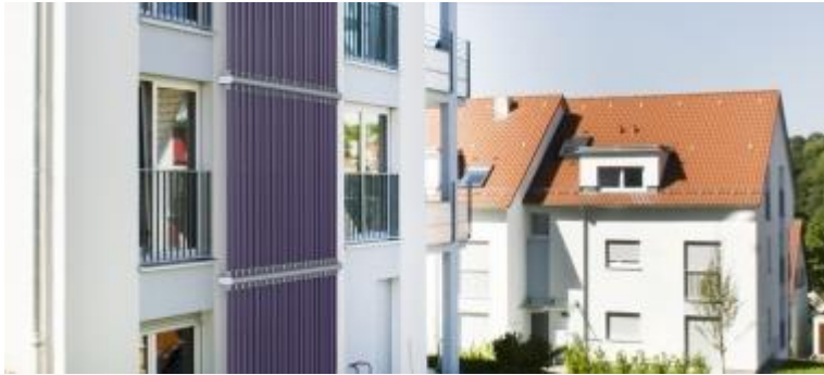
Abbildung 43: Fassadenanbringung von Vakuumröhren der Firma airwasol [15]
