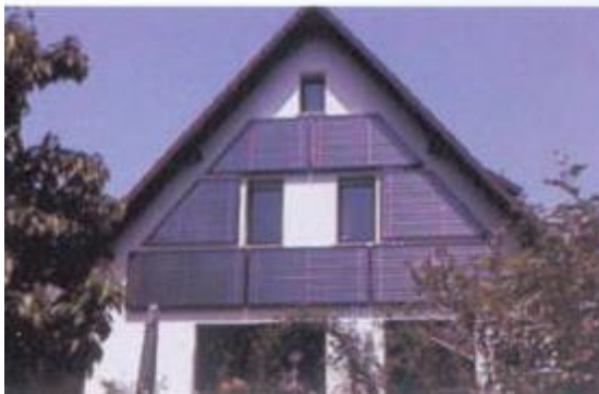
Abbildung 27: Trapezförmige Flachkollektoren mit Konzentratoroptik von Solarfocus, Auszug aus einem Werbeprospekt
