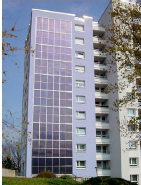
Bild 12 130 m² SOLARroof Fassadenkollektor in Esslingen
